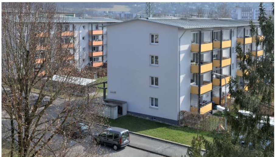
Bei den Häusern Kolpingstraße 21-23 und 17-19 hatte 2006 die Sanierung begonnen.
