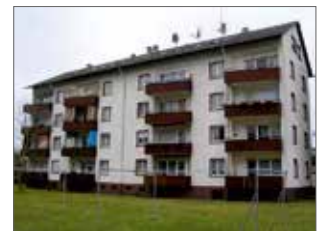
Ortmattstraße vor der Sanierung
