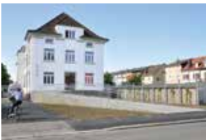
Geschäftsgebäude mit neuem Vorplatz
