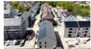
Noch Baustelle, Luftbild
