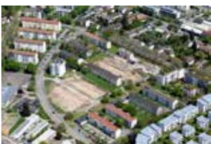
Die beiden Baufelder Luftbild: Meyer
