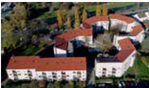
Wölblinstraße nach der Sanierung
