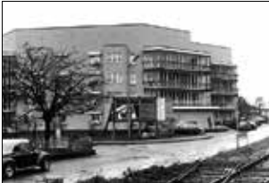
Wölblinanlage beim Bau 1980
