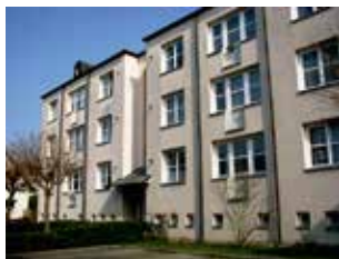
Zustand vor der Sanierung
