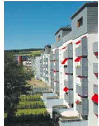
Teichmatten: Saniert und aufgestockt
