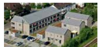
I. Bauabschnitt Dammstraße
