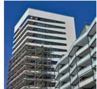
Neubau Leibnizweg 7, rechts Leibnizweg 5 / 6 saniert
