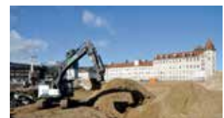
Aushub für das Wohnquartier „Conrad“
