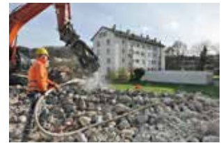
Abbrucharbeiten für das neue Quartier Schlichtergasse
