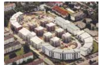
Wohnanlage Stadion im Bau
