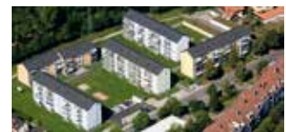
Sanierte Häuser Wiesenweg
