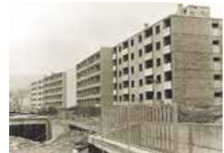
Teichmatten im Bau
