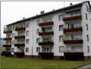
Schlichtergasse 8/10 vor dem Abbruch
