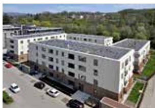
Dachaufsicht mit Photovoltaik
