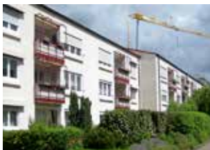
Wölblinstraße 3 nach der Sanierung
