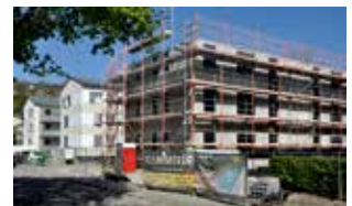
Neubau mit Gerüst
