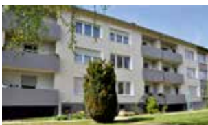
Breslauer Straße vor und nach der Sanierung
