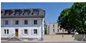
Gasthaus „Mättle“ mit Biergarten nach der Sanierung
