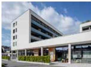
Neubau Mühlestraße mit Biomarkt PrimaCasa und Bäckerei und Café Organic Bild: Dirk Altenkirch
