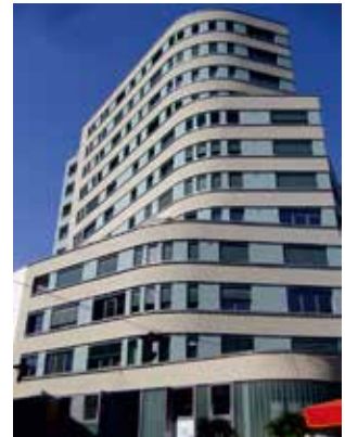
Die Wohnbau Lörrach betreut das Wohnhaus Chesterplatz 8
