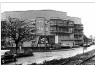
Wölblinanlage beim Bau 1980
