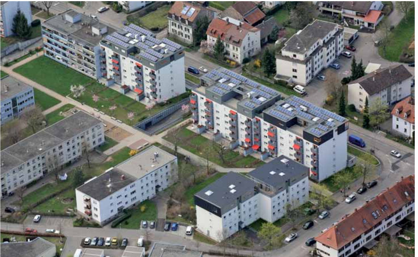
Der östliche Teil des Wohnquartiers aus der Vogelschau: oben im Bild sanierte Gebäude mit Penthouse-Wohnungen und Solaranlagen an der Mühlestraße, unten die ebenfalls erneuerten Häuser Mühlemattweg 2-4 sowie Teichmattenweg 20.
