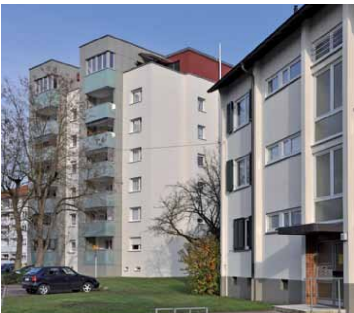
Das Haus Wintersbuckstraße 30 (links), saniert und aufgestockt.
