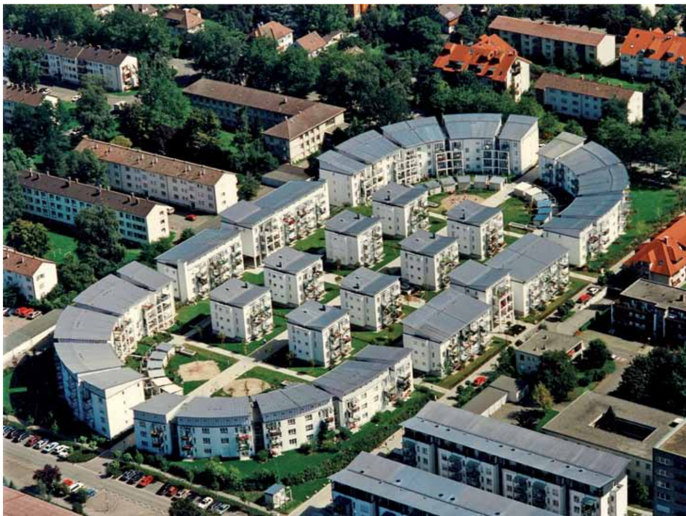
Das „Stadion“ ist die markanteste Wohnanlage in ganz Lörrach. Beim Bau ab 1990 war sie landesweit das größte (und bald preisgekrönte) Projekt des sozialen Wohnungsbaus. An diesem Ort in der Nordstadt lag früher das Städtische Stadion.
