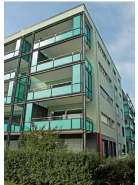
Die Kolpingstraße 8 ist als Neubau eingefügt, mit Gemeinschaftsraum und Gästeappartement im Erdgeschoss.
