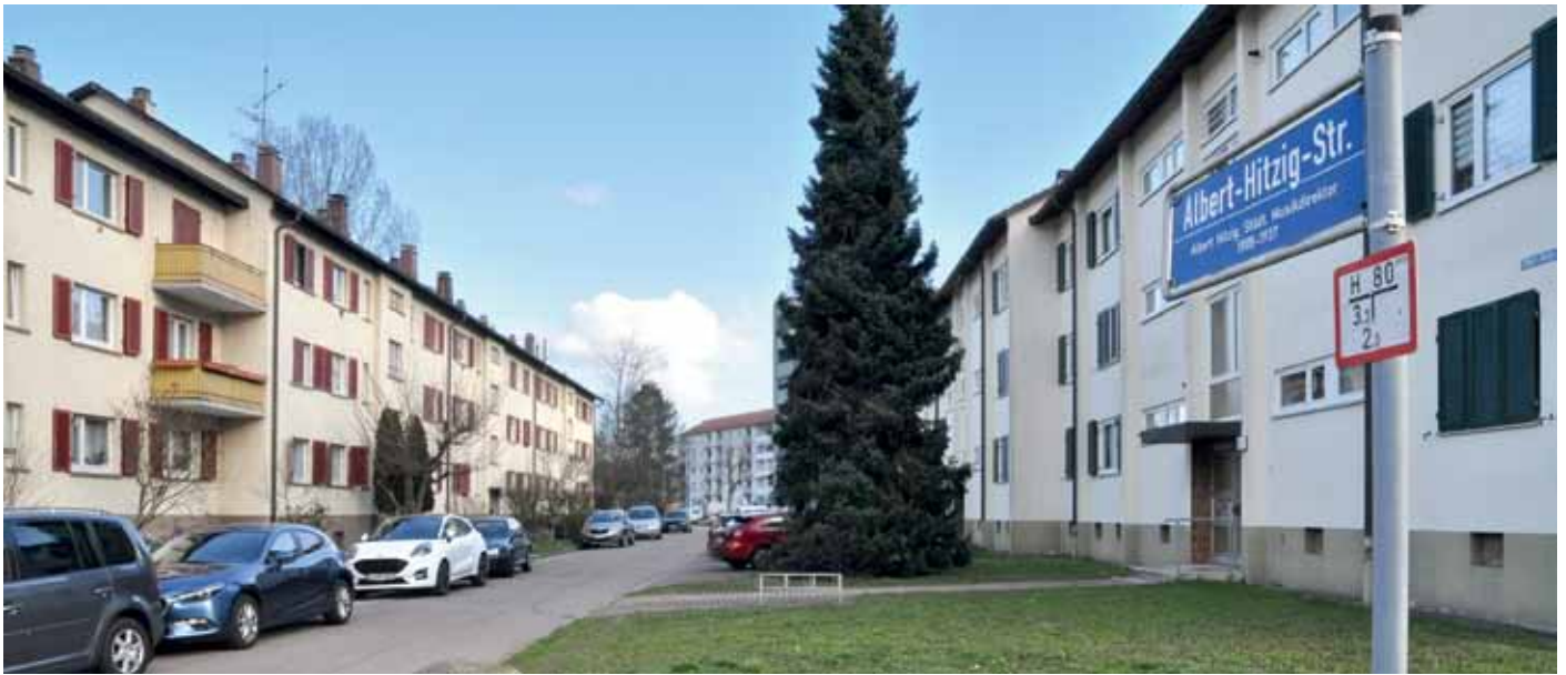
Das sind zwei von vier alten Häuserzeilen in der Nordstadt, die abgerissen werden. Hier entstehen doppelt so viele moderne Wohnungen.
