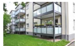
Nach der Sanierung mit neuen Balkonen
