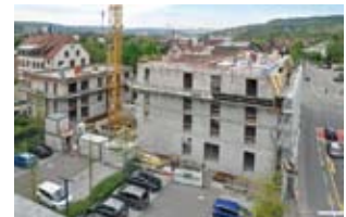
Baustelle Freiburger-/ Mühlestraße
