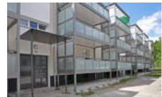
Nach der Sanierung mit neuen Balkonen
