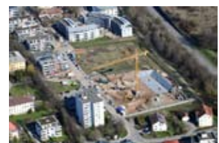
Luftbild Baustelle Foto: Erich Meyer
