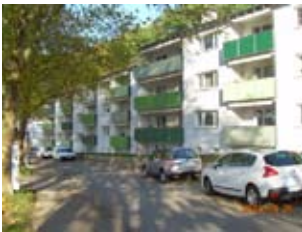
Die Gebäude Carl-Maria-von-Weber-Straße 19 - 23 (oben) und Hangstraße 52 - 58 (unten) wurden saniert und in Wohnungseigentum umgewandelt.
