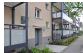
Der Eingangsbereich nach der Sanierung
