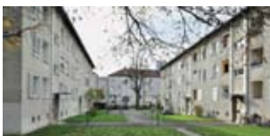
Austraße 6a-c (links) und 8a-c vor der Sanierung
