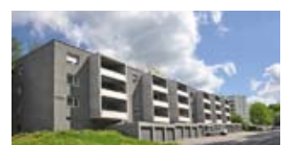
Salzertstraße 41 bis 45 vor und nach der Sanierung
