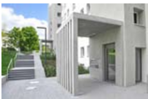
Salzertstraße 59 bis 63 nach der Sanierung
