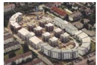
Wohnanlage Stadion im Bau
