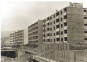
Teichmatten im Bau
