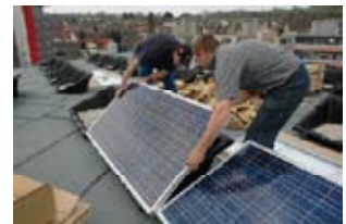
Fotovoltaikanlage im Bau
